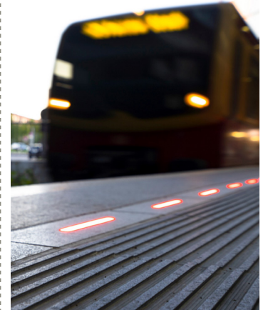
Leuchtende Bahnsteigkante am Gleis 1 Berlin Südkreuz Foto: DB / H.-C. Plambeck
