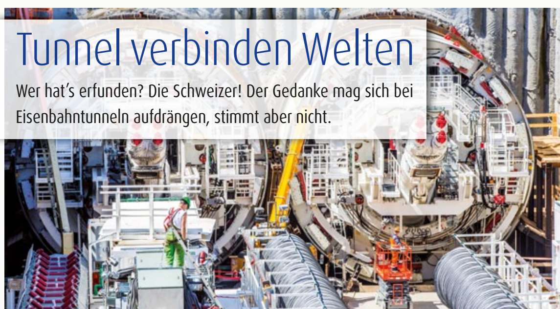
Zwei Schildmaschinen für den Albvorlandtunnel
