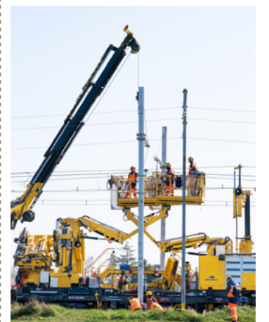
TSO-Zug erneuert Oberleitungen im 1.500-Volt-Netz
