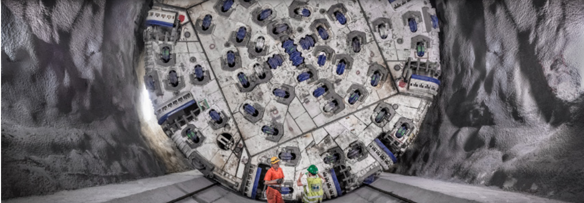
Vortriebsstart am Brenner Basistunnel
