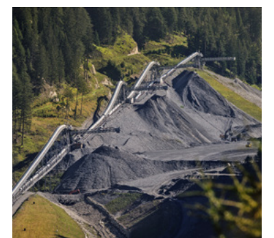
Förderbandanlage am Brenner Basistunnel (Deponie Padastertal)
