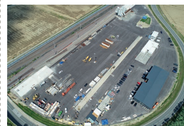
Baustelleneinrichtung für die bahntechnische Ausrüstung am Koralmtunnel
