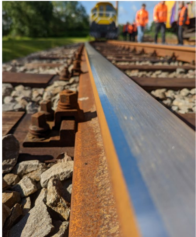
Reprofiled rail after milling and finishing Reprofilerte Schiene nach Fräsen und Finish
