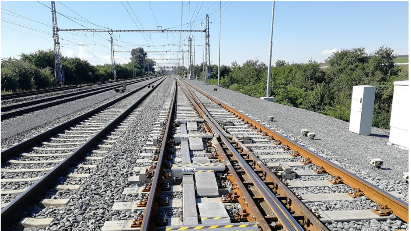
High-speed turnout in Prosenice, the Czech Republic Hochgeschwindigkeitsweiche in Prosenice, Tschechische Republik
