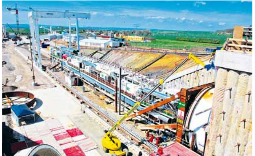
Le tunnelier au milieu du grand chantier.
