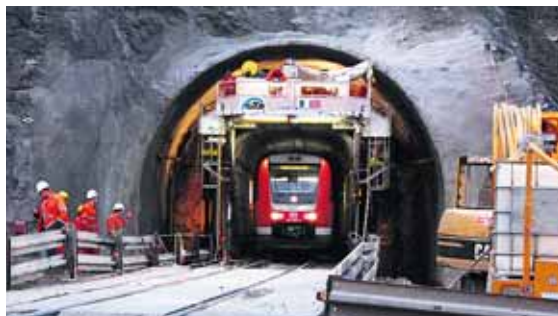
Grâce au nouveau procédé, il est possible d'effectuer des travaux dans un tunnel sans stopper le trafic ferroviaire.
