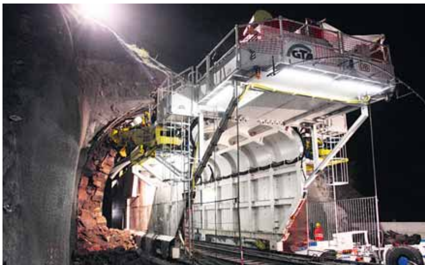
La machine conçue pour le principe du tunnel dans le tunnel a également été utilisée pour la réhabilitation du tunnel de Jährod en Rhénanie-Palatinat. Photos : DB ProjektBau GmbH/Matthias Oettel
