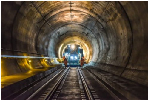
Reinigung des Gotthard-Basistunnels
