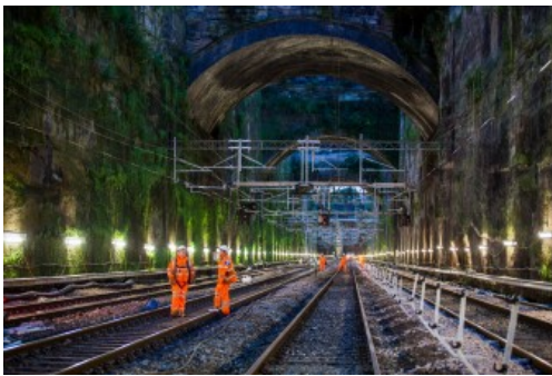
Liverpool Lime Street – Kabelkanalsystem-Installation als Wandbefestigung
